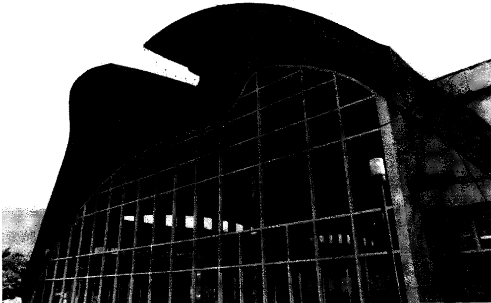
FIGURA 1.7 Casarón esférico en Medellín, Colombia. Las superficies de borde en voladizo proporcionan rigidez al domo lateral.
