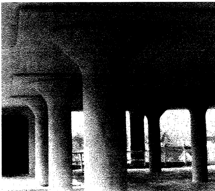
FIGURA 18.8 Entrepiso de losa plana en un garaje de estacionamiento.
