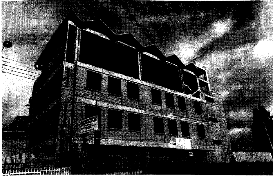
FIGURA 1.5 Cubierta de placas plegadas con una luz de 12 metros que, además de soportar las cargas normales de cubierta, sostiene el cuarto piso mediante un sistema libre de columnas interiores.
