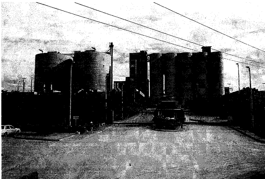
FIGURA 1.11 Tanques circulares de concreto utilizados en instalaciones para almacenamiento de malta en Cartagena, Colombia.
